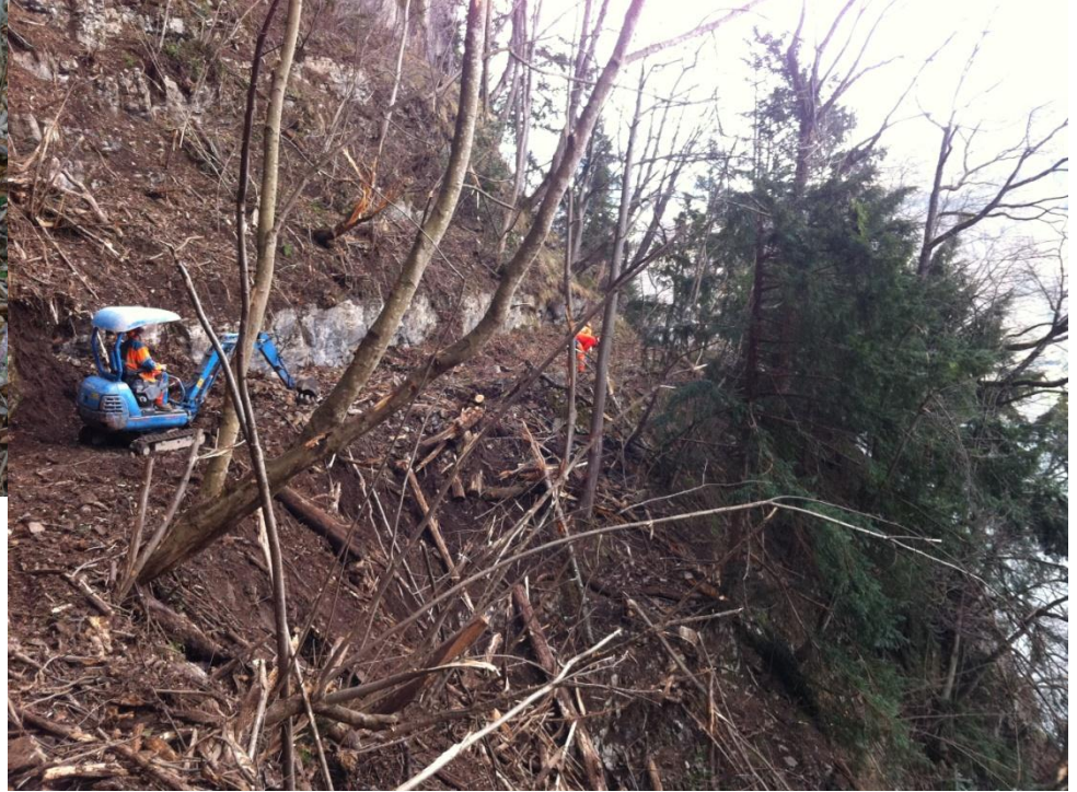
Salleren West: Felsräumung und Waldschlag für Netzinstallation (2013)
