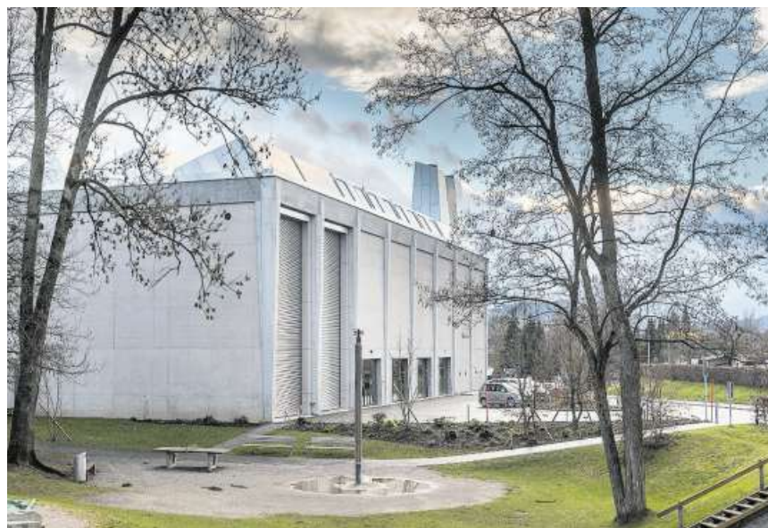
Trotz ihrer Grösse ist die Fernwärmezentrale Teil des Parks.
