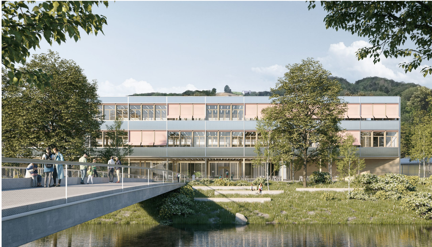
Kantonsschule Wattwil → Grundsteinlegung
